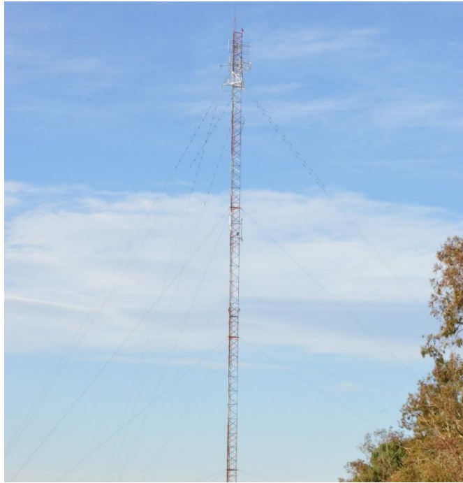
FOTO.13- Antena F.M- Radio Enlace
