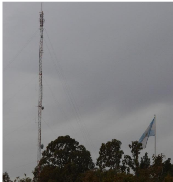
FOTO.9- antena de T.V publica –Radio Enlace- Canal 7
