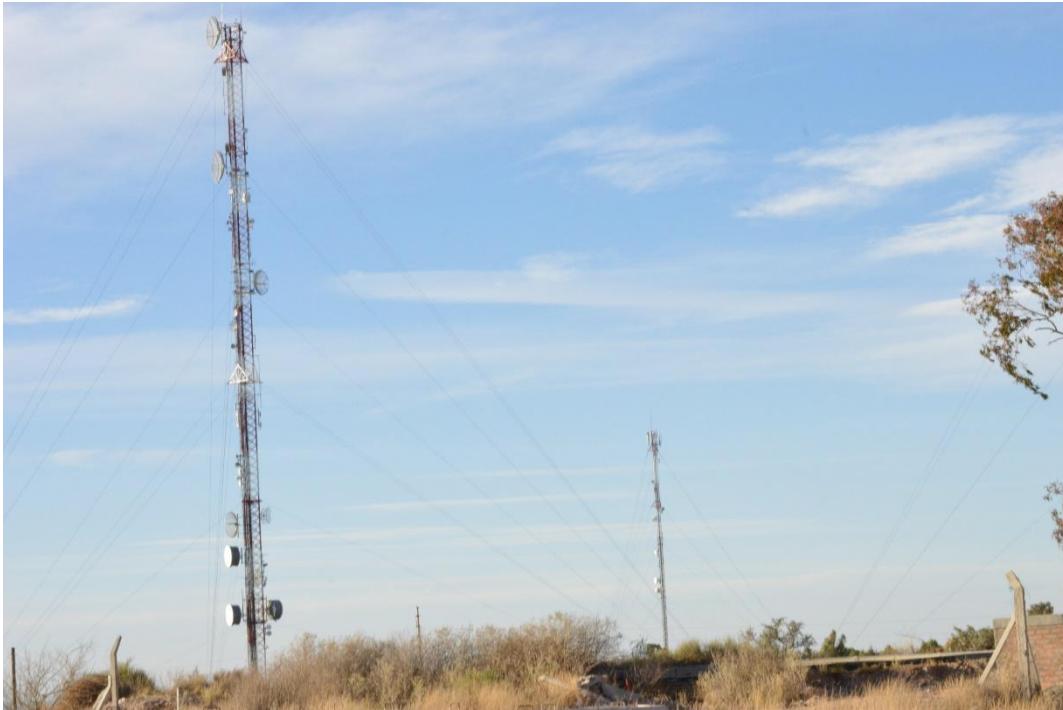
FOTO.11- Antena TGS- de comunicación – Radio Enlace
