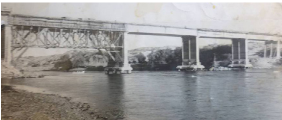
Puente en Construcción. Año 1968
