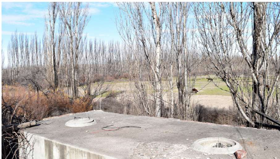
Boca Piletones Bodega "El Parralito". Fuente: CETRIP.
