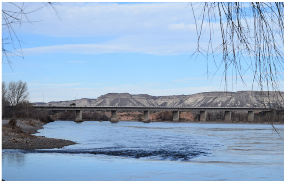
Puente Paso Córdoba. Año 2016. Fuente: CETRIP
