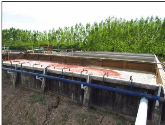
Figura 3.19 Tanque compensador con aireación
