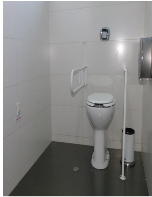
Ilustración 76: BAÑO DEL LOBBY
