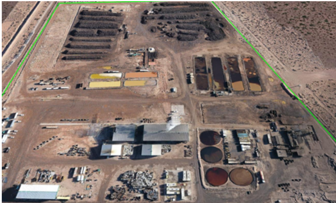
Figura 1. Vista panorámica de la planta de tratamiento.
