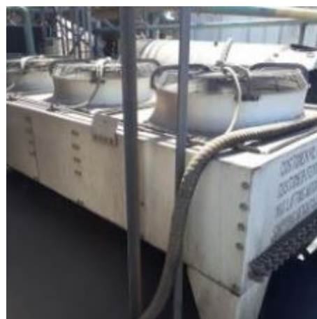
(b) Aeroenfriador del Knock Out Pot .
