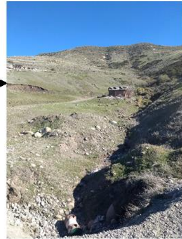
Imagen 5: construcción sobre cañadón aluvional
