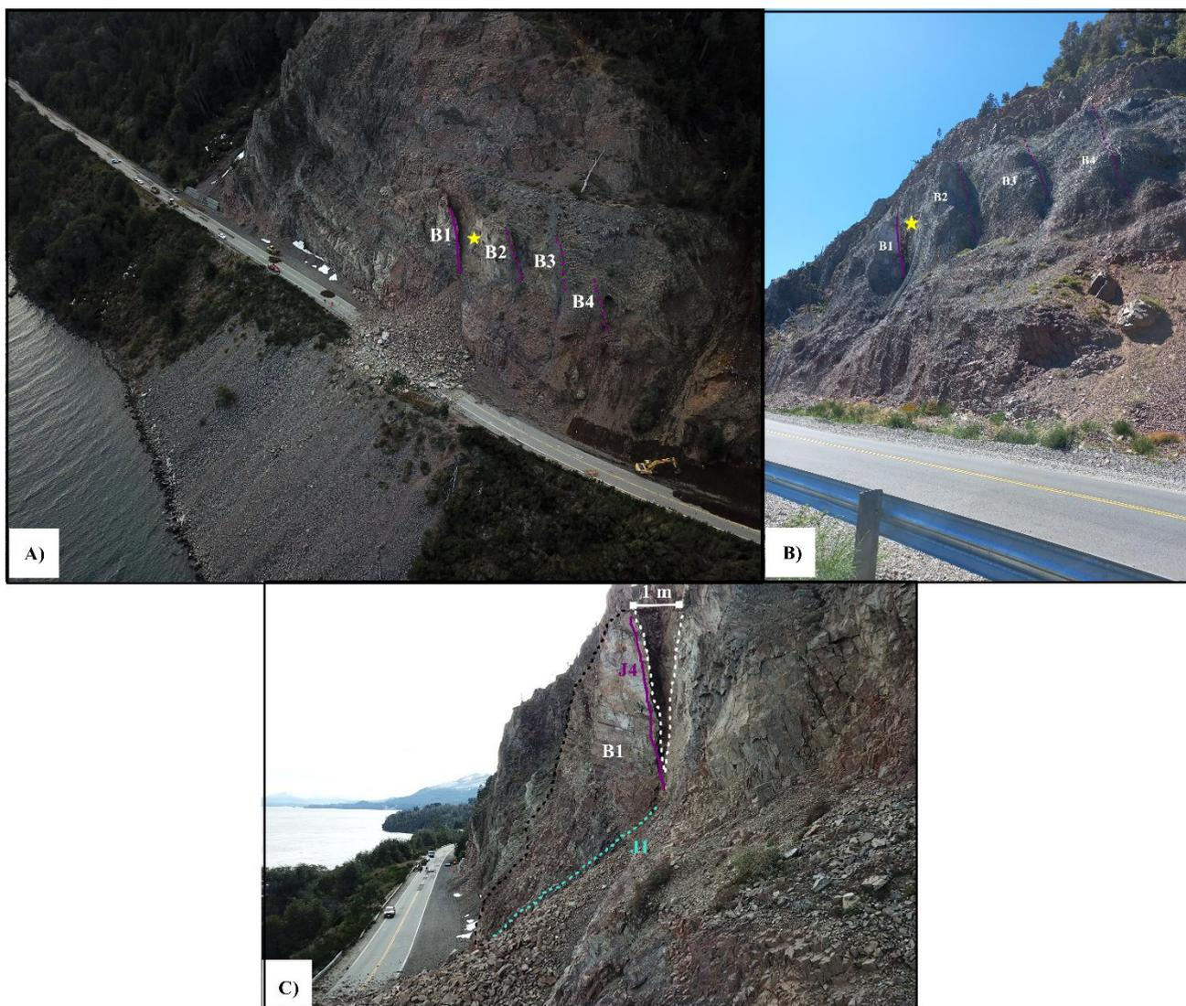
Figura 28: A y B) Delimitación de los bloques B1 a B4, dentro del sector 4 del talud, que podrían fallar por vuelco en el futuro. Las líneas continuas y discontinuas violetas representan las diaclasas de la familia J4 que delimitan el lateral de los bloques. La estrella amarilla indica la ubicación del bloque que falló en el evento de remoción en masa del año 2019.
