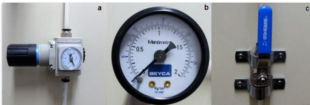
Figura 3.3.3: a) Regulador de presión. b) Manómetro. c) Válvula esférica.
