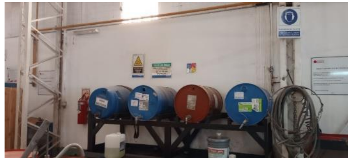
Figura N°4: Acopio de productos químicos
