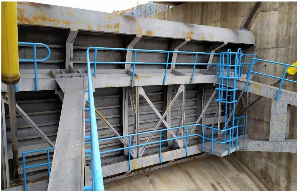
*Figura 3.3: Compuerta radial de vertedero del Complejo Hidroeléctrico Los Reyunos correspondiente al Sistema Diamante, ubicado en la provincia de Mendoza.*
