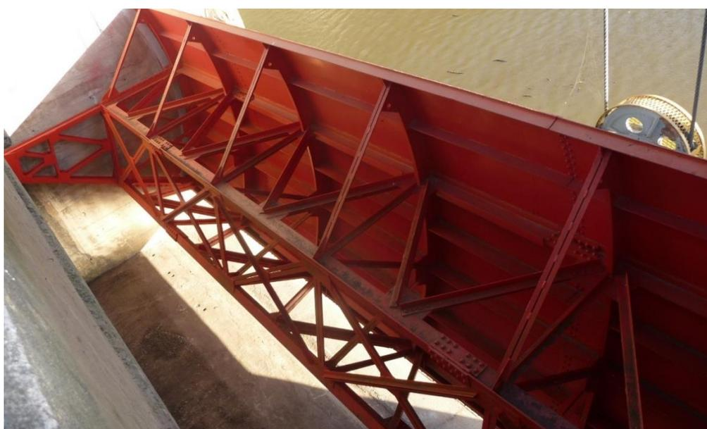
Figura 3.2: Compuerta de segmento de vertedero del Complejo Hidroeléctrico Escaba ubicado en Tucumán.
