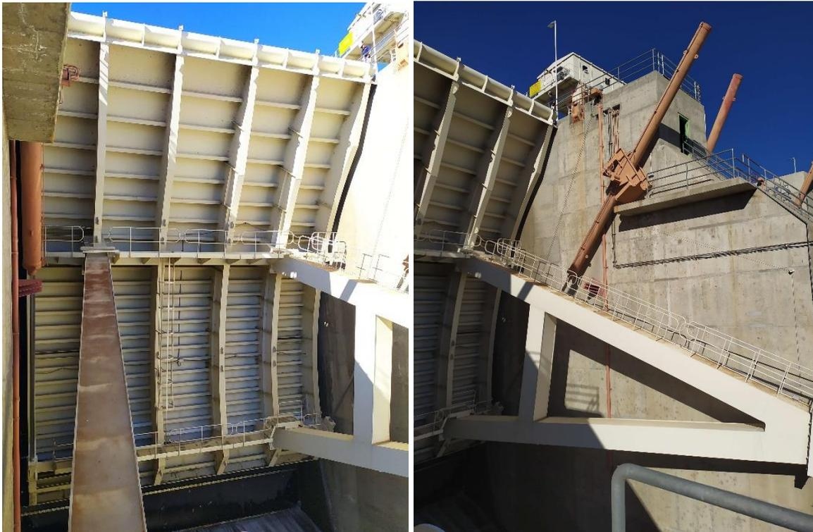
*Figura 3.10: Compuerta de segmento del vertedero del Aprovechamiento Hidroeléctrico Piedra del Águila.*
