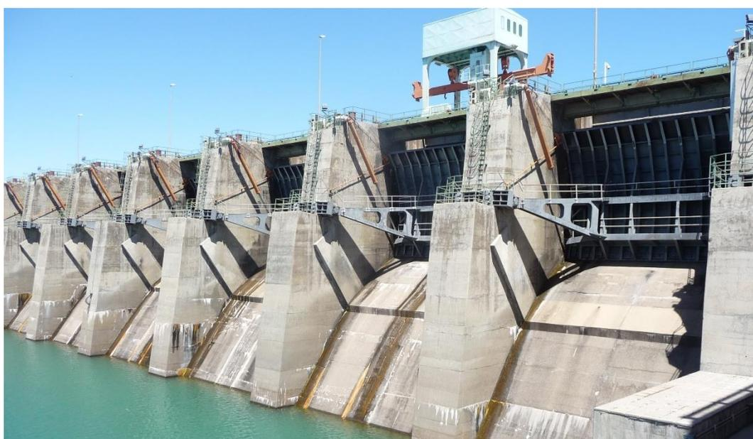
*Figura 3.4: Compuertas radiales del vertedero del Compensador del Aprovechamiento Hidroeléctrico El Chocón, ubicado en Arroyito, provincia de Neuquén.*
