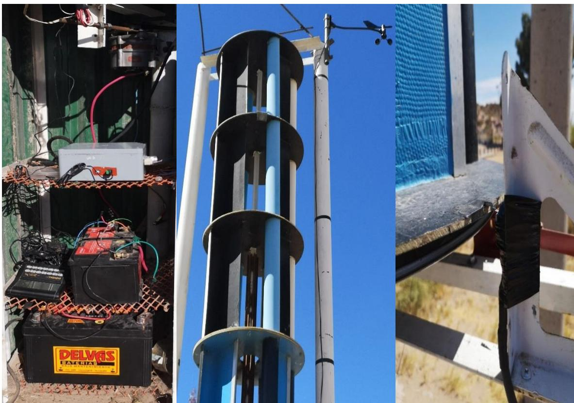
*Figura 24: Montaje del equipo electrónico y anemómetro en el aerogenerador.*
