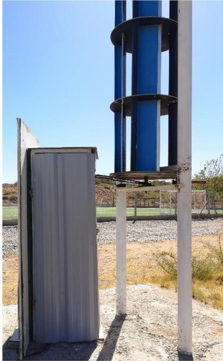
Figura 22: Aerogenerador de eje vertical y gabinete
