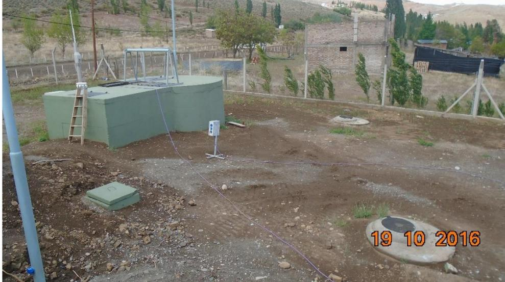
*Fotografía 3 – Vista exterior de Pozo de Bombeo, malacates de izaje y Tablero de Operación y Control.*
