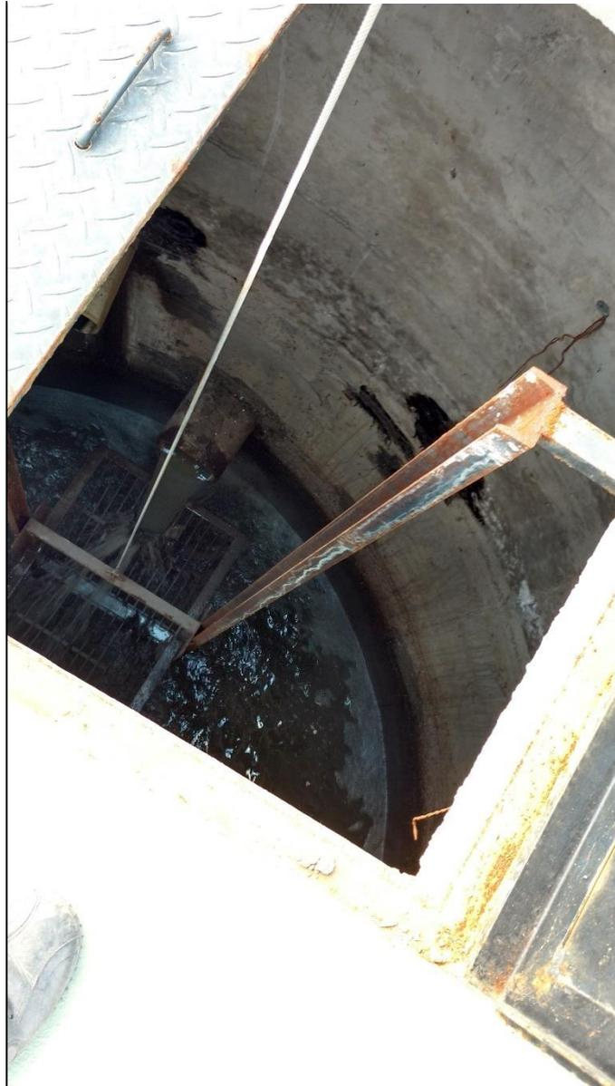
*Fotografía 5 – Vista exterior de Cámara de Rejas Finas – Cañería de impulsión.*
