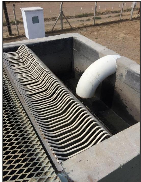
*Fotografía 7 – Vista de Vertedero Triangular, Canaleta lateral de Distribución, interior del Tanque de Aereación, Parrilla de Difusores.*
