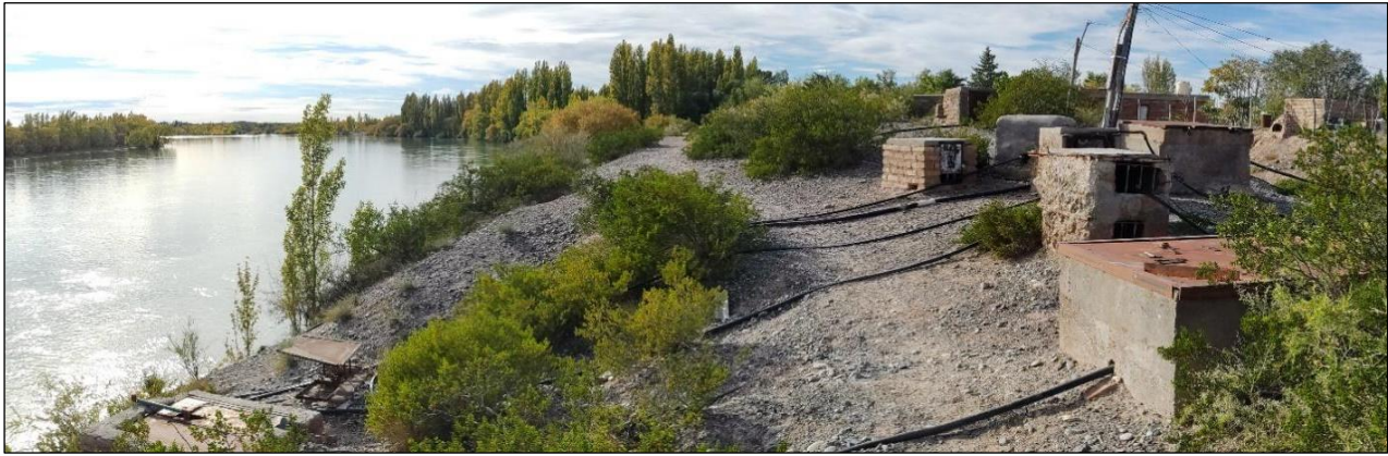
Figura 4. Instalaciones para extracción de agua del río Limay para uso domiciliario
