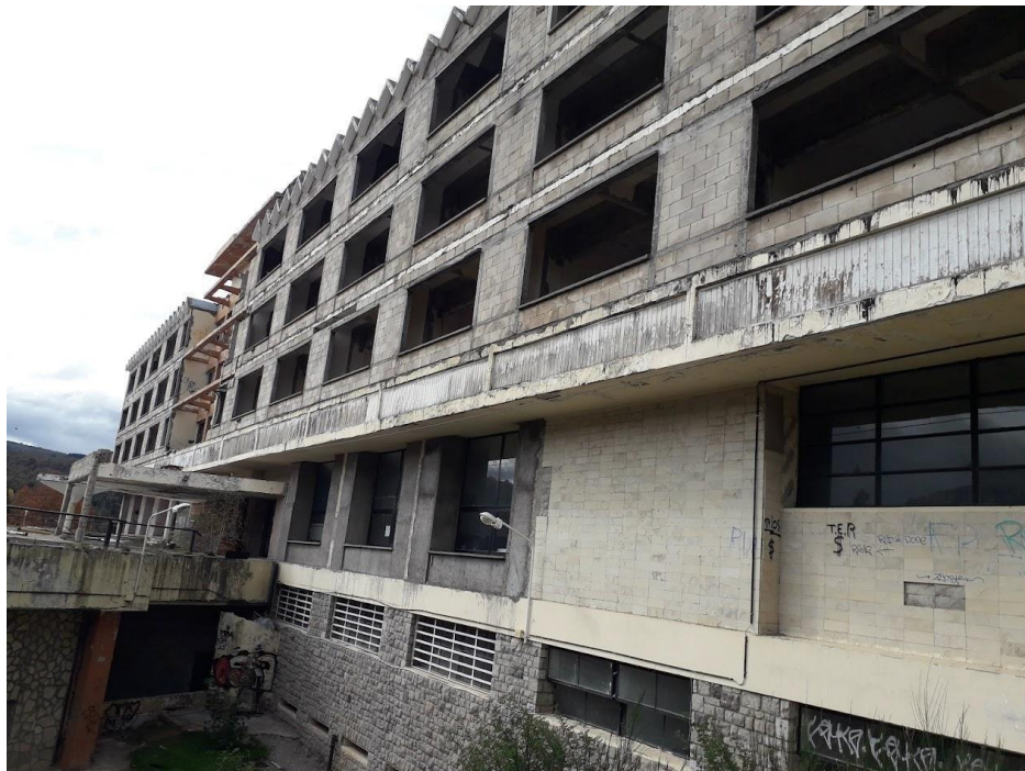
Vista fachada Oeste desde la derecha - Elaboración propia
