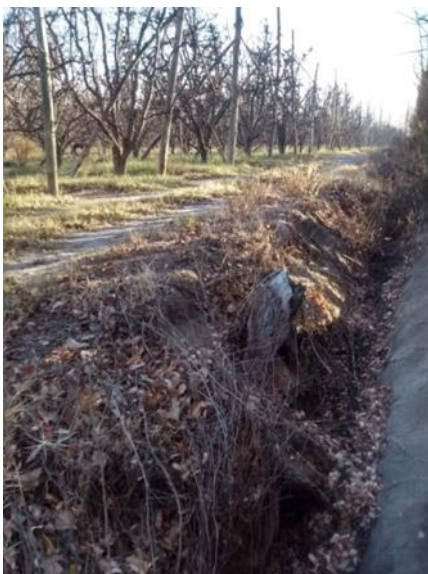
Figura 21. Desagüe a cielo abierto.
