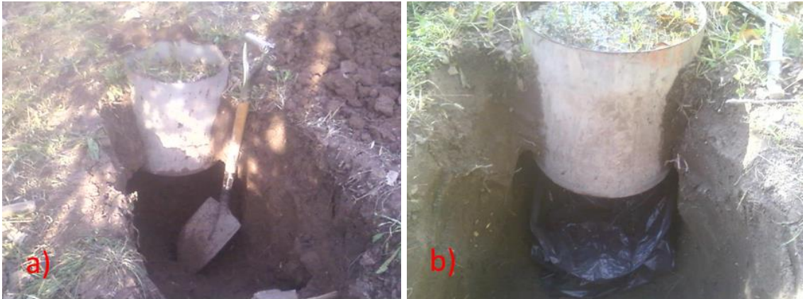
Figura 35. a) Instalación del anillo de infiltración b) Aplicación y recolección de agua.
