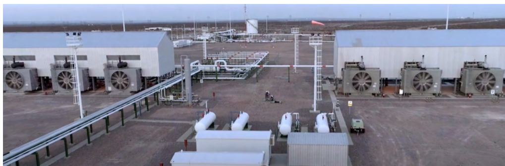
Figura 1. Vista general de la Planta.
