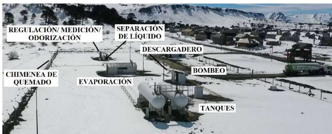
Figura 11. Fotografía de planta de almacenamiento de GLP tipo ( https://www.hidenesa.com.ar/ ).
