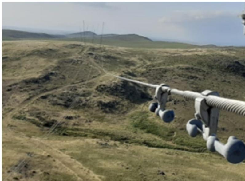
Figura 2. Detalle sistema amortiguante en cable de guardia LAT 500 kV.
