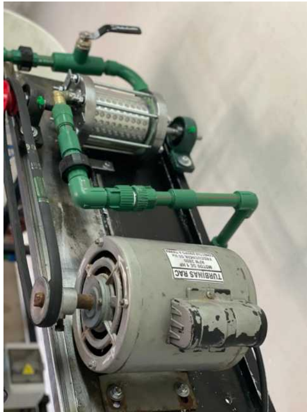
Figura 6.38. Montaje de motor y reactor.
