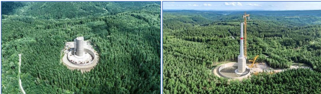
Figura 4.10 – Construcción de torre de hormigón y posterior montaje de torre de acero. (Max Bögl AG Wind, 2020)
