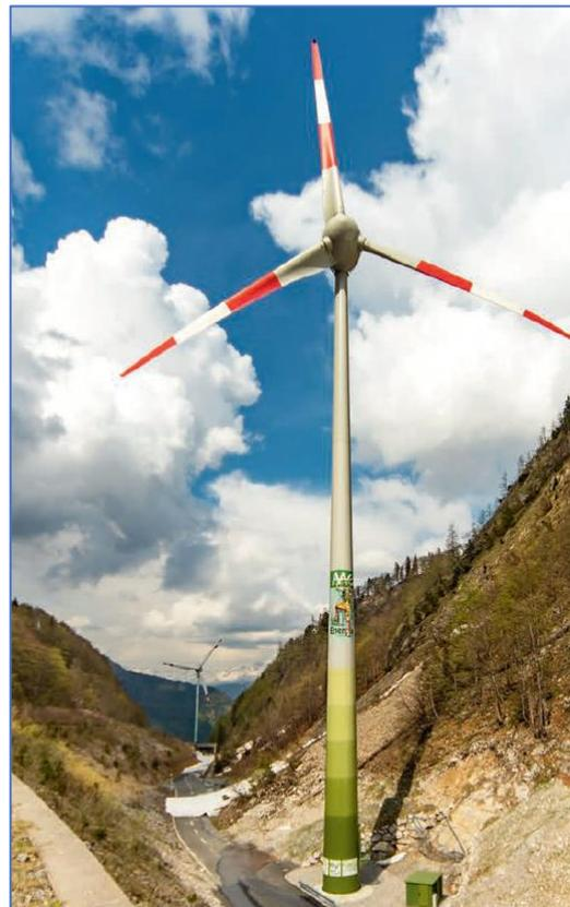
Figura 4.18 – Aerogenerador Enercon E-53, de 800 kW. Reducción del impacto ambiental. (Catálogo Enercon, 2019)
