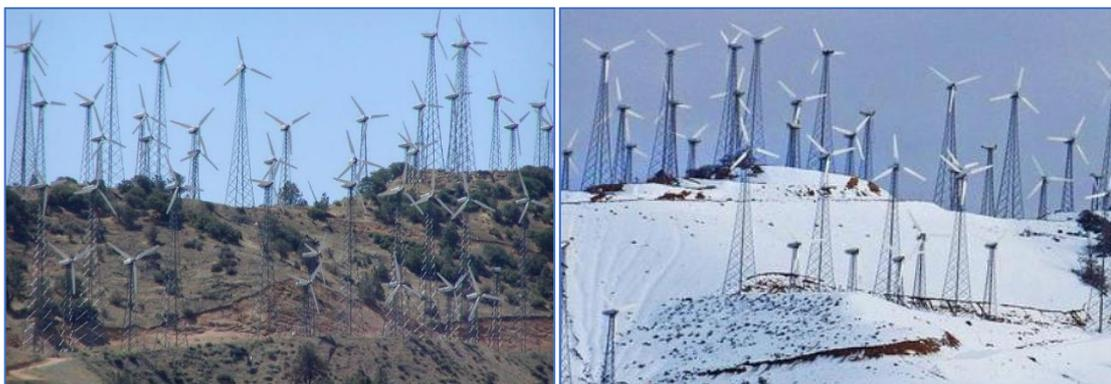
Figura 4.1 – Impacto visual de torres reticuladas con tensores. Parque eólico Tehachapi construido en la década de los 80 (Wikipedia, 2020)
