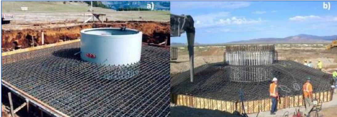
Figura 3.8 – a) Sistema de fijación torre-cimentación mediante tubo embebido; b) Sistema de fijación mediante conectores de acero. (Núñez Ayala, 2015).
