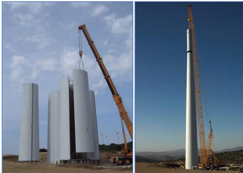
Figura 4.2 – Montaje de torres de hormigón. (Infopower, 2009)
