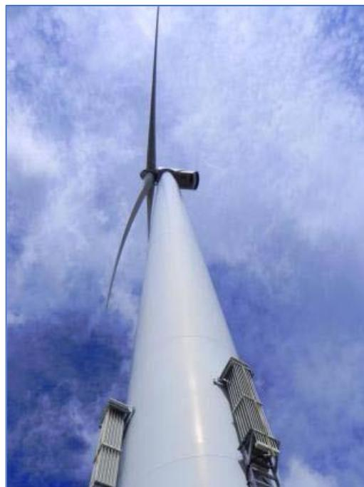
Figura 4.5 – Torre eólica tubular de acero. (EDPR Renovables, 2014)
