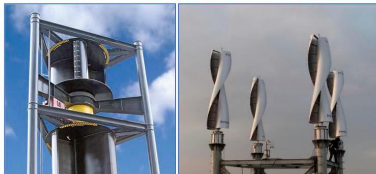
Figura 3.9 – A la izquierda un aerogenerador del tipo Savonius típico; a la derecha un aerogenerador del tipo Savonius helicoidal. (ABB Cuaderno Técnico: Plantas Eólicas, 2012)
