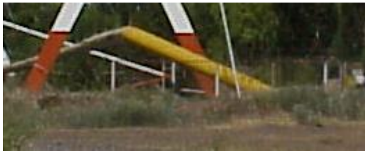
Figura 2.19: Tramos extremos del ducto. Empotramiento. –propia-
