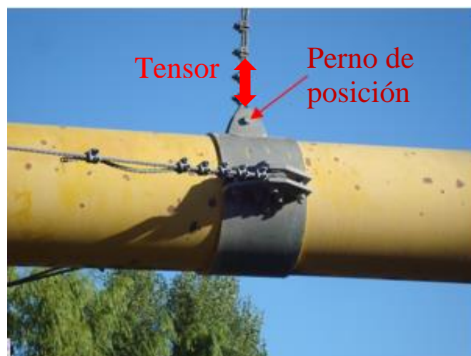
Figura 3.5. Tensor para retesado y punto para control del desplazamiento. -propia-
