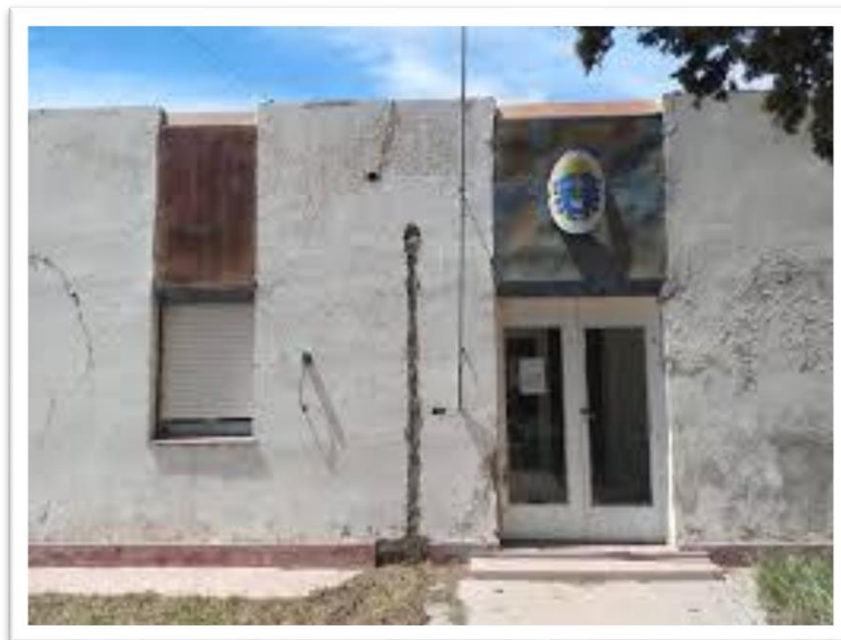
Fotografía 3 - Puerta principal de acceso del Viejo Hospital Rural Dolavon
