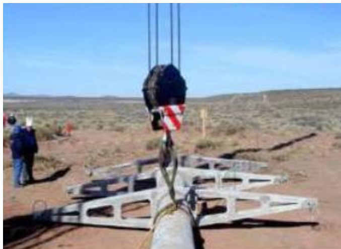
Figura N°04: Trabajos en la Estación Transformadora.
