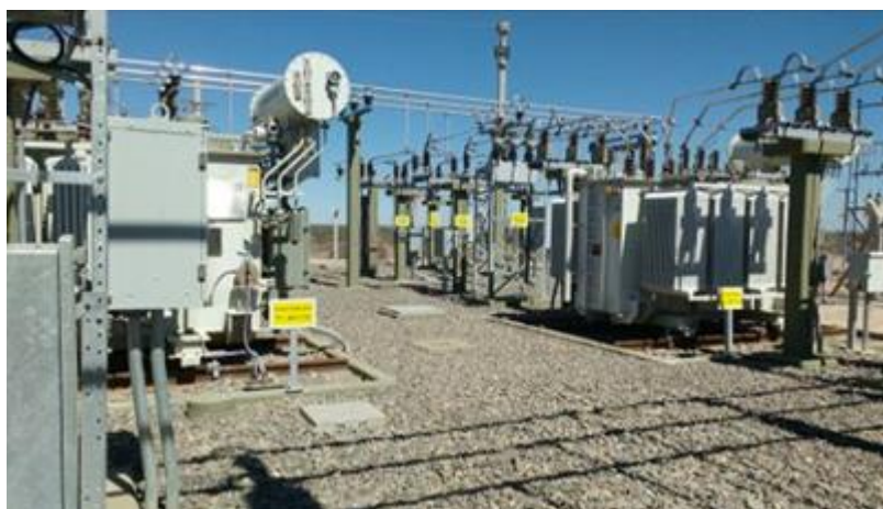
Figura N°02: Trabajos en la Estación Transformadora.
