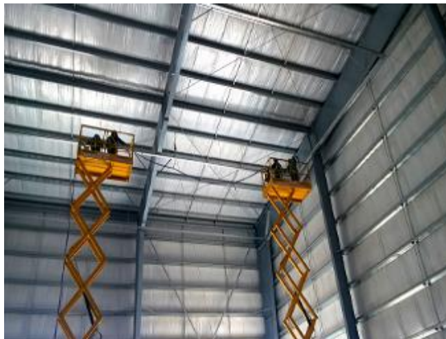
Figura N°05: Trabajos en Altura.
