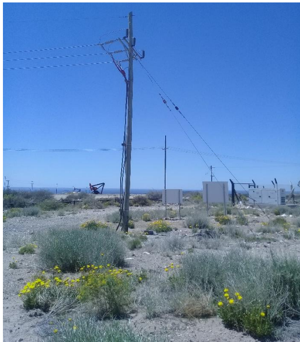
Figura N°12: Trabajos de mantenimiento en la línea.
