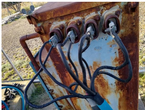
Figura N°10: Reparación del aislamiento del reg.
