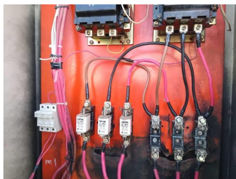
Figura N° 09: Reparación de Tablero.
