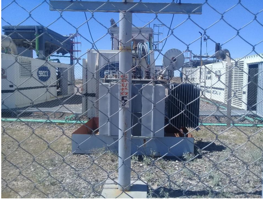
Figura N°11: Trabajos de mantenimiento en OB 1181.
