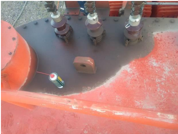
Figura N° 08: Lavado de Transformador
