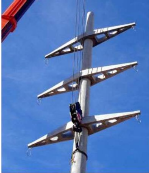
Figura N°03: Trabajos en columna de Hormigón.
