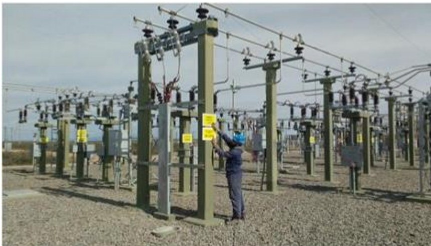
Figura N°01: Trabajos en la Estación Transformadora.
