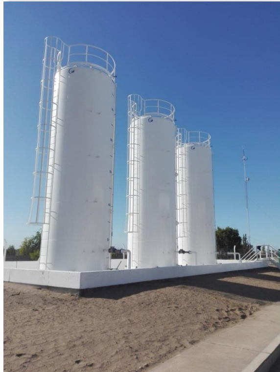
Figura 36. Tanques aéreos de 60m 3 de capacidad para el despacho a granel.
