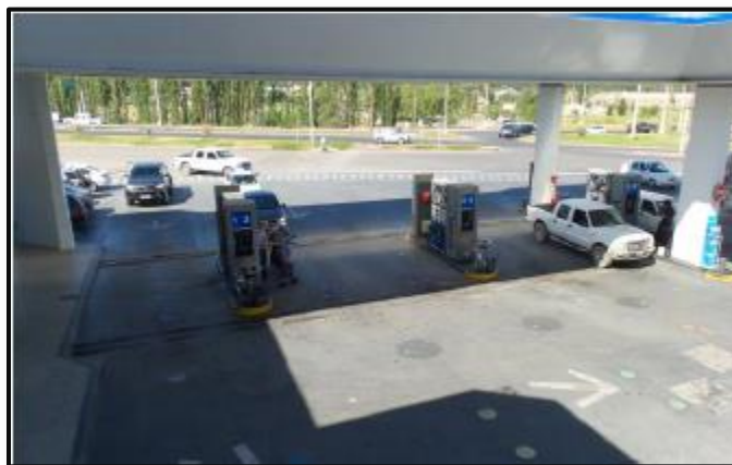
Figura 26. Vista de la playa de expendio de combustibles.
