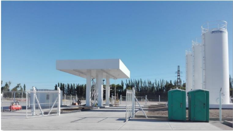
Figura 37. Vista lateral de la playa de expendio a granel en su etapa constructiva.
