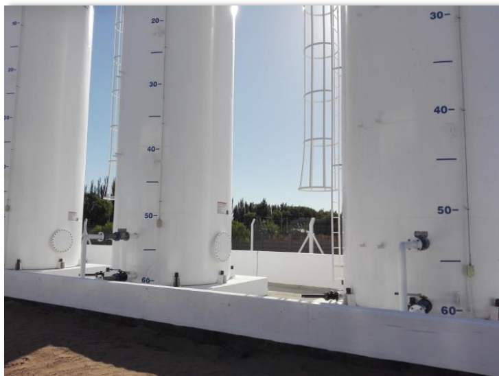
Figura 36. Tanques aéreos de 60m 3 de capacidad para el despacho a granel.
