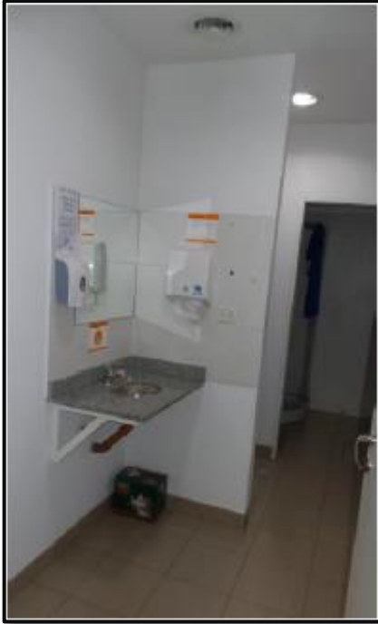
Figura 24. Grupo sanitario y sector de refrigerio para empleados.
