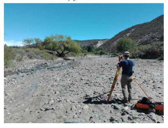
Figura 10: Relevamiento topográfico con estación total.
