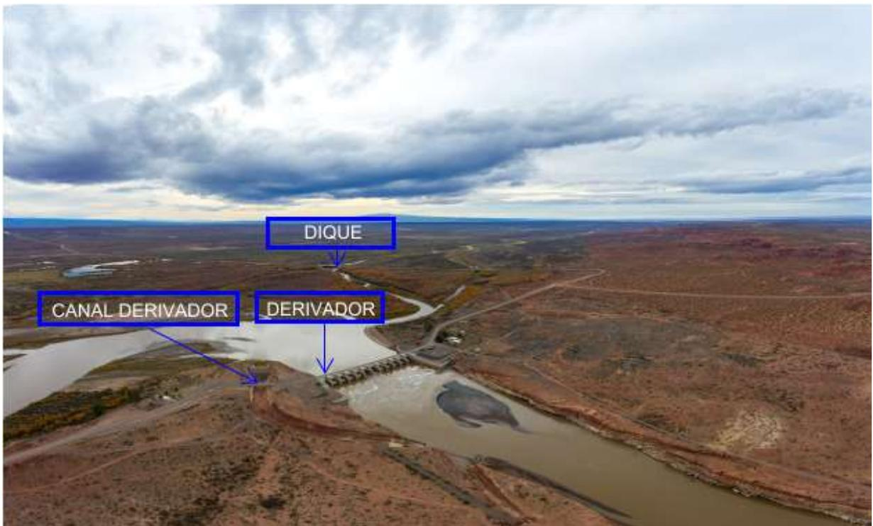
Figura I-9 – Portezuelo Grande Dique, Derivador y Canal Derivador.
