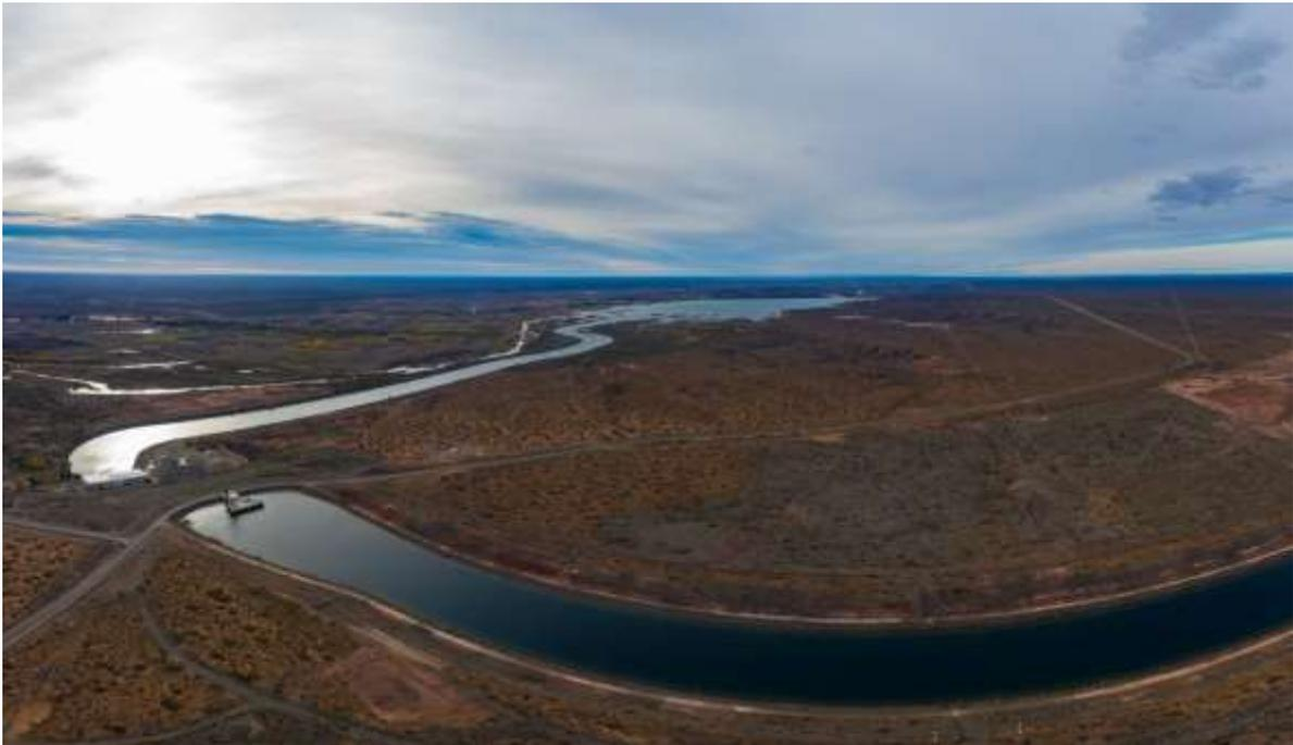
*Figura I-15 – Presa Planicie Banderita con canal de aducción y canal de restitución, desde aguas arriba.*
