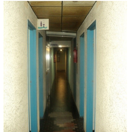
Pasillo baños comunes FaCiMed
