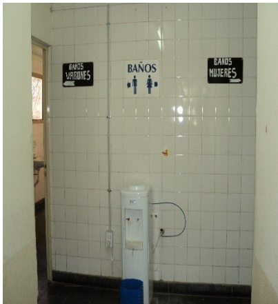
Baños comunes FaCE
