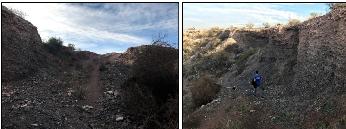
Figura 44: Camino sobre la sección superior de la ladera aleña a la urbanización Balcón de la Ciudad.
