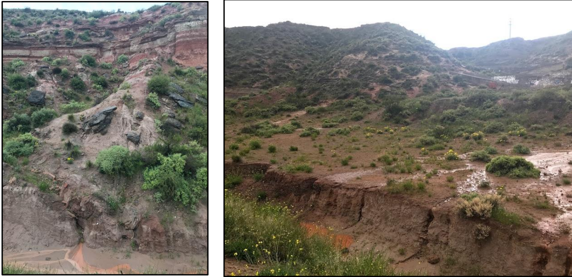
Figura 31: El escurrimiento del agua de lluvia genera cárcavamiento en las laderas neuquinas.
