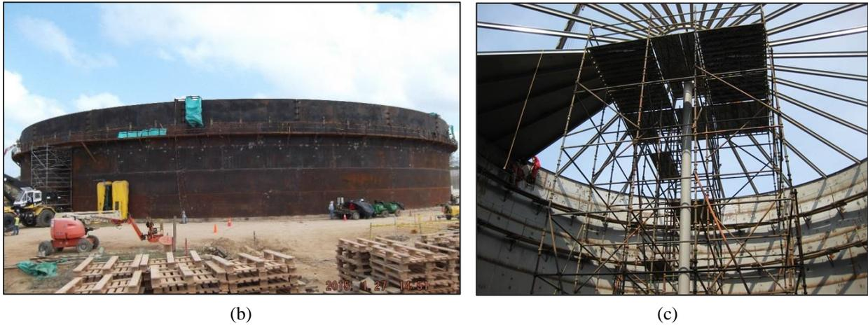
**Figura 2.5:** (a) Fondo del tanque. (b) Envoltente cilíndrica. (c) Estructura del techo.
