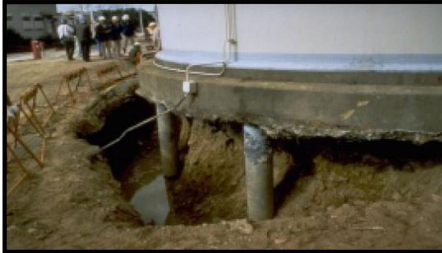
Fig 1.1 Falla de la fundación por licuefacción
