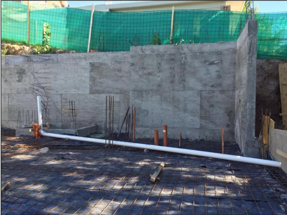
Figura 7-19 Polietileno 200 micrones debajo de fundación
