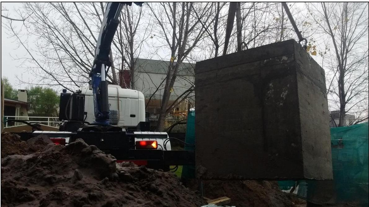
Figura 21 - Colocando cámara principal grua hidráulica
