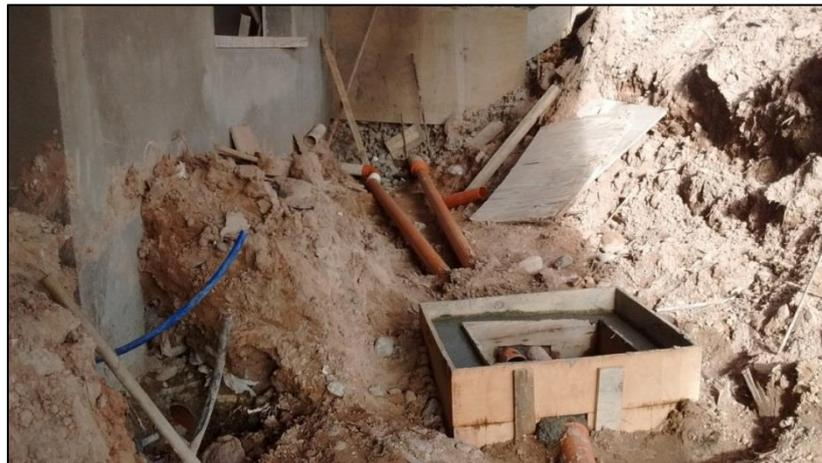
Figura 26 - Cámara de inspección
