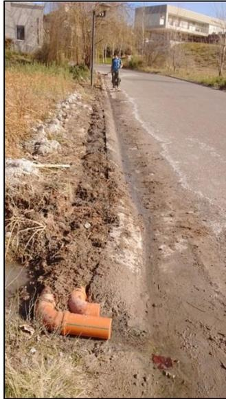
Figura 27 - Cañería proveniente cámara principal a cordón cuneta
