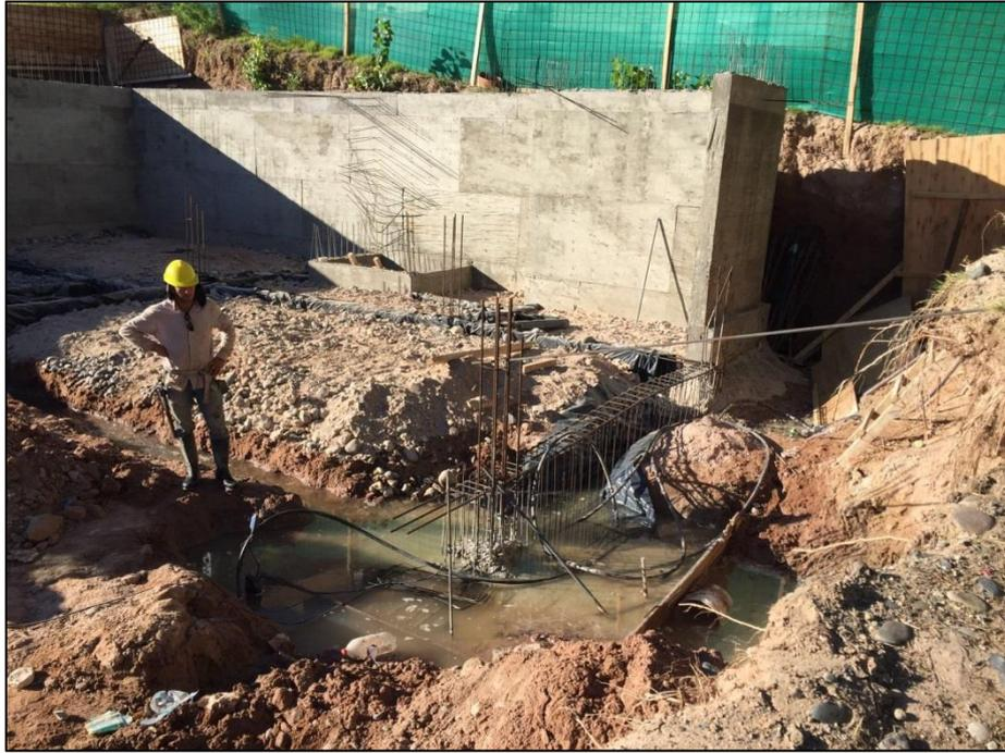
Figura 7-18 Presencia de agua en hormigonado de fundaciones
