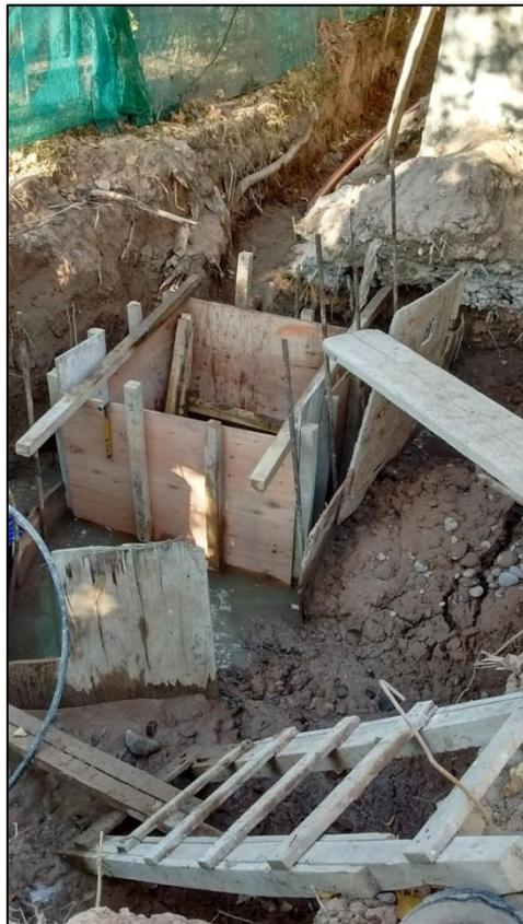
Figura 15 – Encofrado in situ cámara principal
