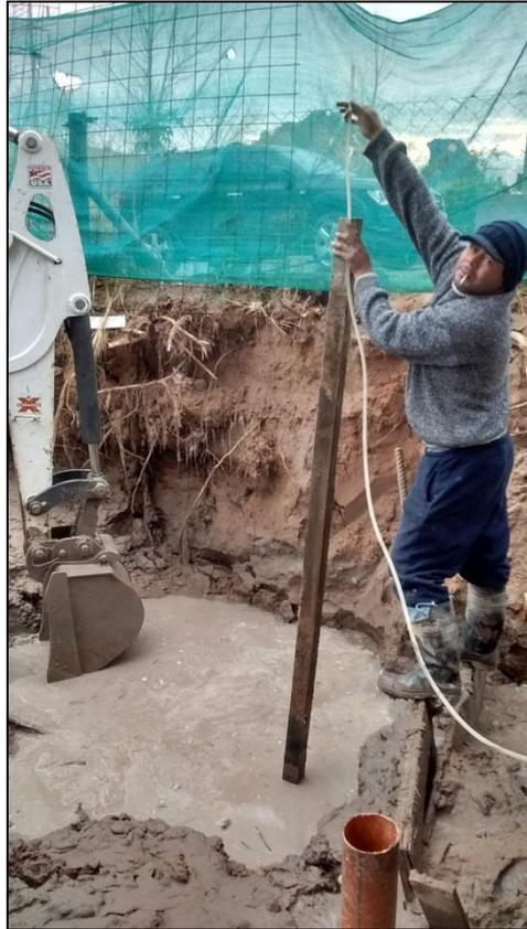
Figura 20 - Verificando nivel excavación
