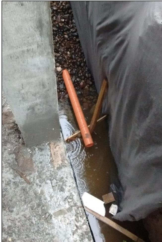
Figura 7-10 Drenaje muro H°A°
