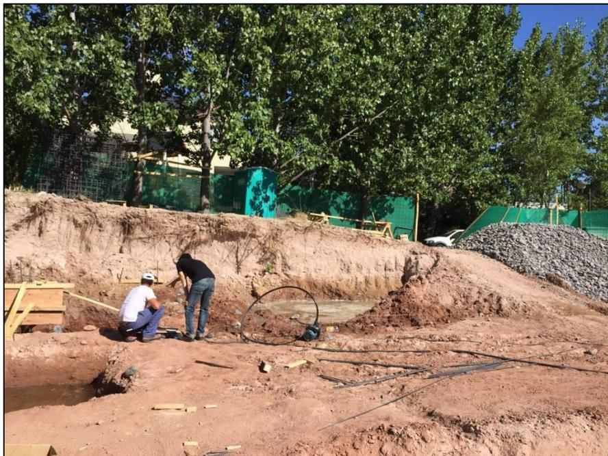
Figura 7-15 Presencia de agua en fundaciones
