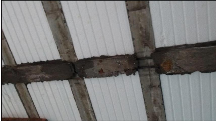
Figura 5-7 Falta de recubrimiento armadura longitudinal
