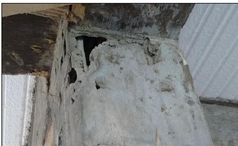
Figura 2-7 – Oquedades columna hormigón
