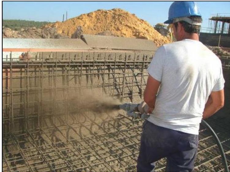
Figura 5-4 Ejemplo aplicación hormigón gunitado
