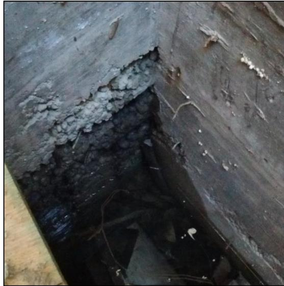
Figura 7-21 Hormigón lavado bajo recorrido ascensor
