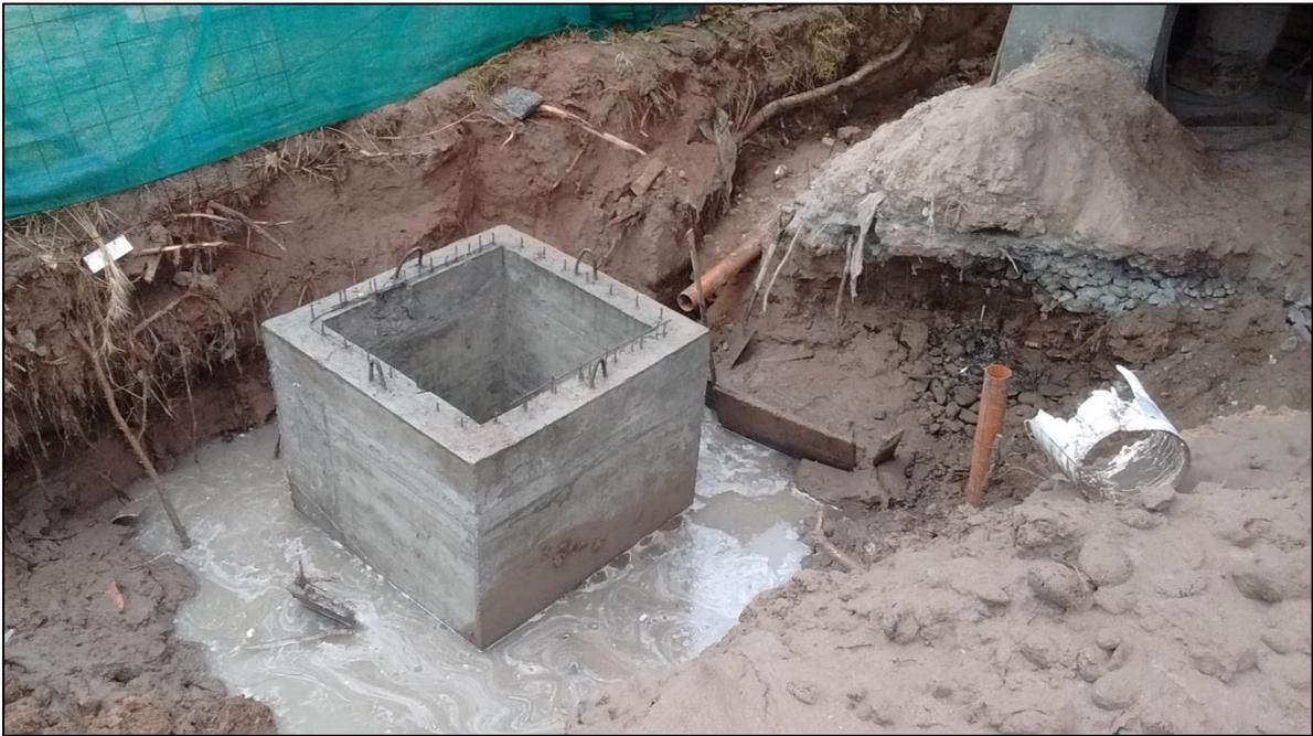
Figura 23 - Cámara principal colocada
