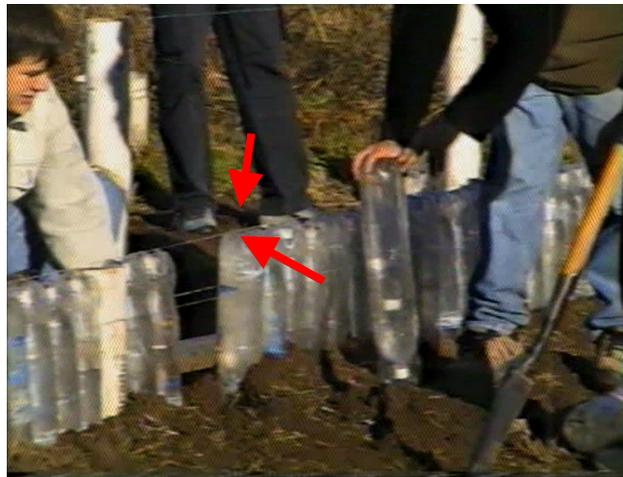
La sujeción y tensión de los alambres se realizan con los tensores para alambre tipo griplas (G)
