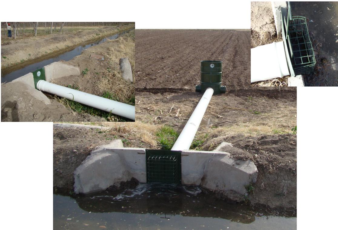
Este elemento fue fabricado con un tacho de 200 lts al que se le soldaron a la altura del fondo tres boquillas a la medida del diámetro de la manga de polietileno a utilizar, en este caso de 8 pulgadas.
