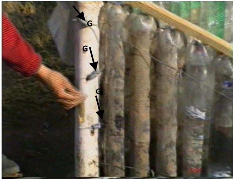
Para la pared frontal de 30 cm de altura, se dispondrán columnas armadas con 2 botellas plásticas con sus respectivas tapas.
