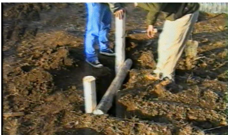
Luego se colocan verticalmente cada 2 metros postes de forma de completar el perímetro de la estructura. Quedando una de las caras al ras del suelo de 70 cm, y la otra cara a 30 cm, tal como se muestra en la foto.
