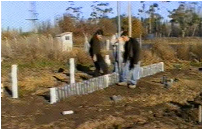
Para la pared de la cara sur de 70 cm se necesitaran armar columnas con 4 botellas plásticas. Finalmente los laterales se irán armando con columnas de botellas en forma escalonada.
