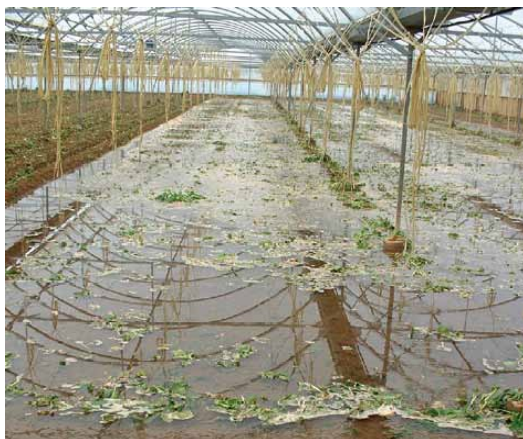
Figura 2: Sellado de la superficie con riego por gravedad.
