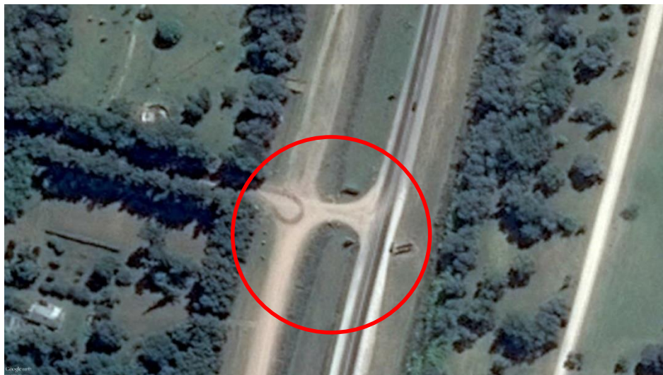
Progr. 0+000 – Inicio de Obra – Intersección con Ruta Prov. N°58
