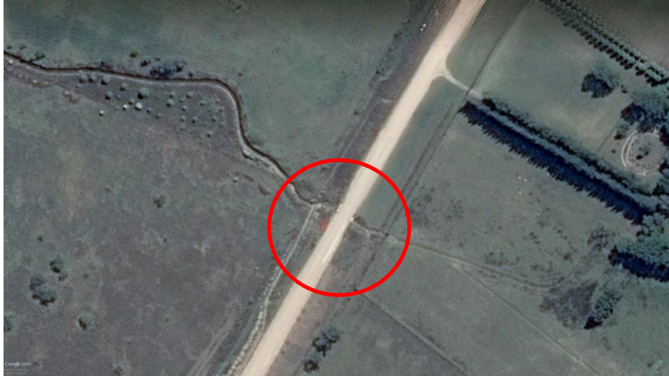
Progr. 3+800 – Alcantarilla existente
