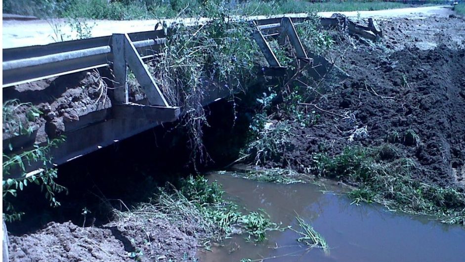
Progr. 0+250 – Alcantarilla a construir / Interferencia Gasoductos
