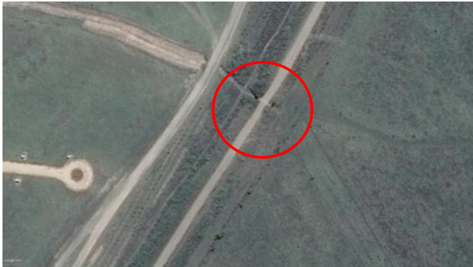
Progr. 5+600 – Alcantarilla a construir
