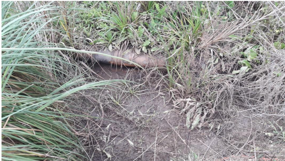
Progr. 6+920 – Interferencia Gasoductos / Alcantarillas a construir
