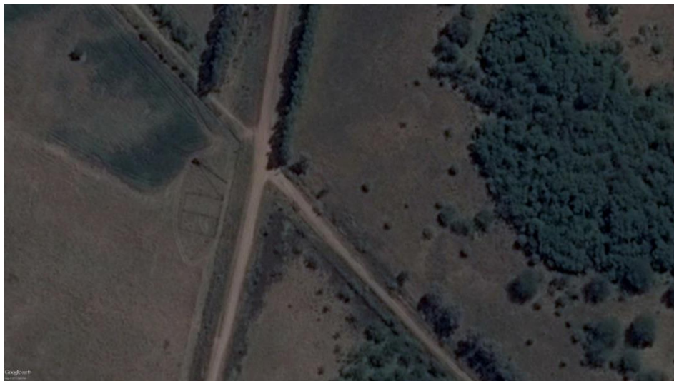
Progr. 9+950 – Fin de obra / Intersección Camino
