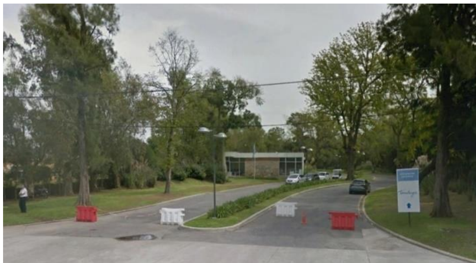
Progr. 1+030 – Ingreso Barrio Privado Terralagos
