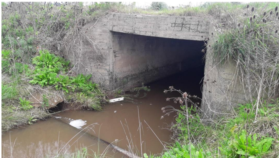
Progr. 3+800 – Alcantarilla existente
