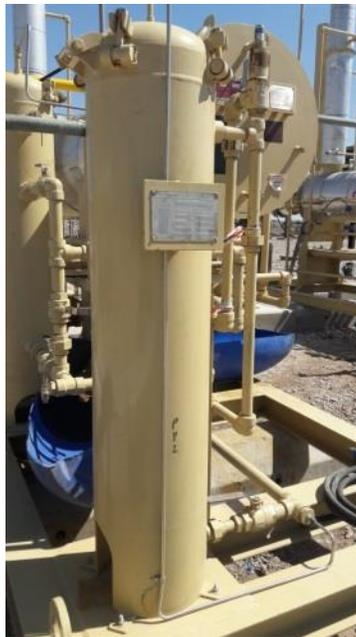
Figura 4.10: Fotografía filtro de carbón activado
