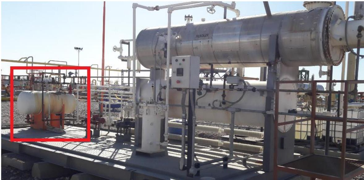
Figura 5.1: Fotografía de Regeneradora con tanque flash
