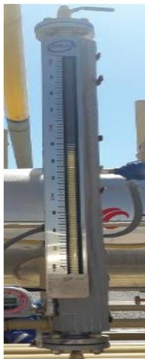
Figura 4.9: Fotografía nivel en reboiler posterior al rebalse
