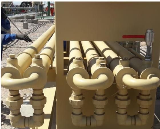
Figura 4.5: Fotografía intercambiador de calor Glicol/Glicol
