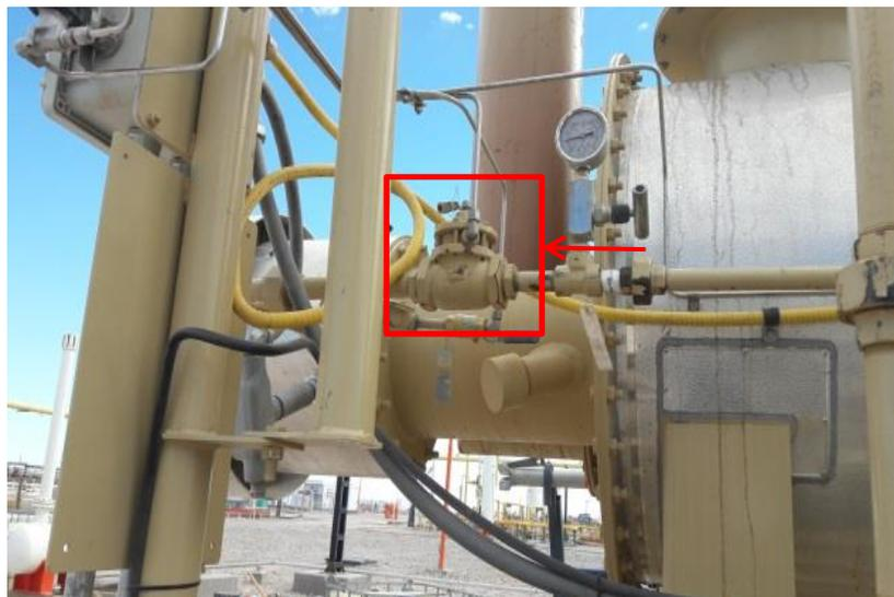
Figura 4.7: Fotografía válvula controladora de temperatura
