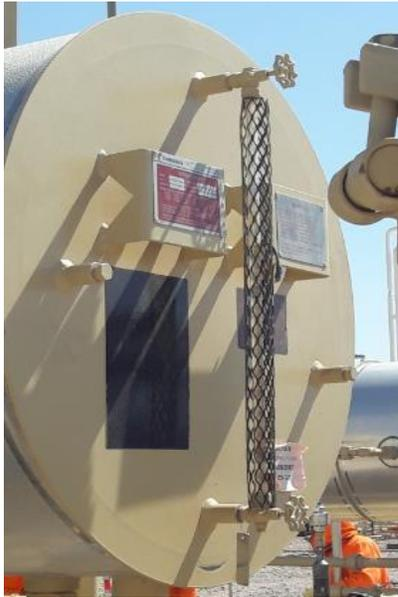
Figura 4.8: Fotografía nivel en reboiler anterior al rebalse
