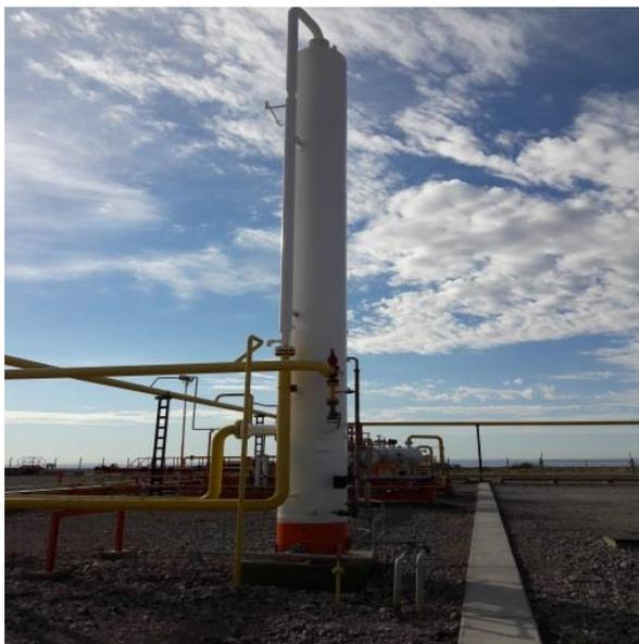
Figura 4.3: Fotografía torre contactora de unidad de deshidratación
